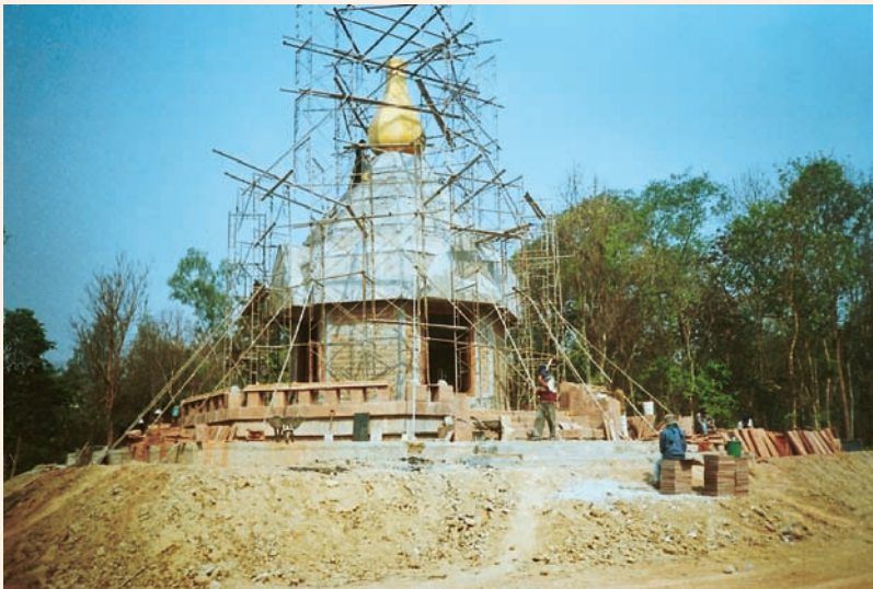
พระมหาธาตุมณฑลปอนุสรณ์มูรพาจารย์ วัดป่าอาจารย์มั่น (ภูริทัตโต) อยู่ระหว่างการก่อสร้าง ถ่ายเมื่อ ๑๕ มีนาคม ๒๕๔๕
